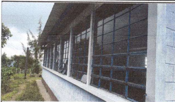
FOTO 7: Sustitución de balcones de metal
