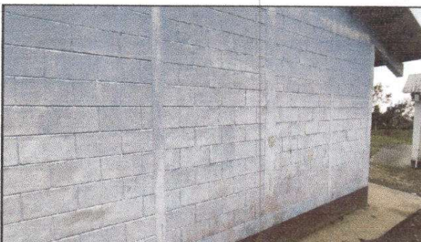
FOTO 10 : Pintura en muros exteriores e interiores
