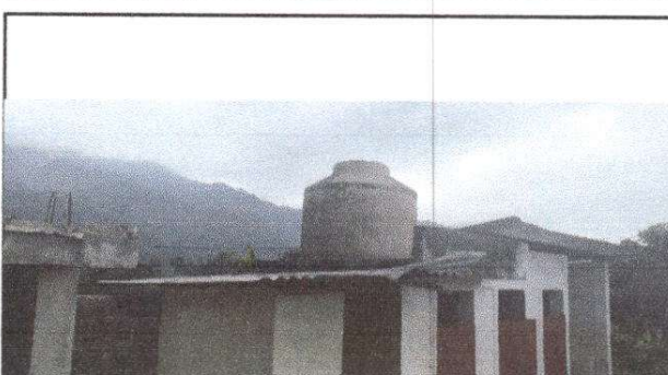
FOTO 4: Sustitución de depósito de agua 1100 lt
