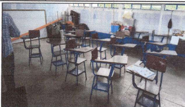
FOTO 8: Sustitución de piso de cemento líquido
