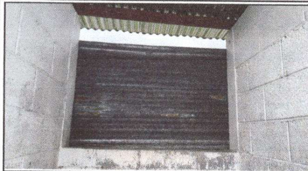
FOTO 1: Fabricación e instalación de ventana-balcon de metal
