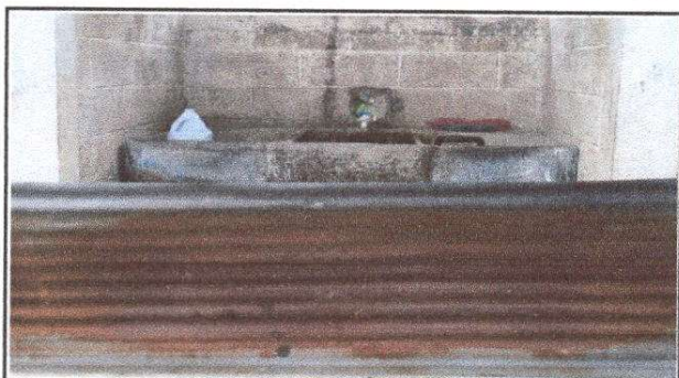
FOTO 3: Sustitución de barandas de metal.
