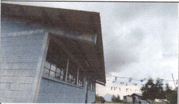
FOTO 9: Sustitución de canal de metal, Reparación de bajada de agua pluvial, tubo PVC 3" Y Sustitución de soporte o pescante de metal para canal.
